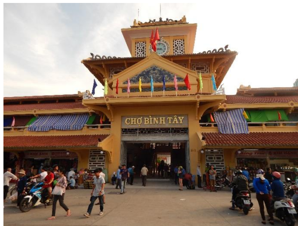
Chợ Bình Tây ngôi chợ lớn nhất thành phố (quận 6)
